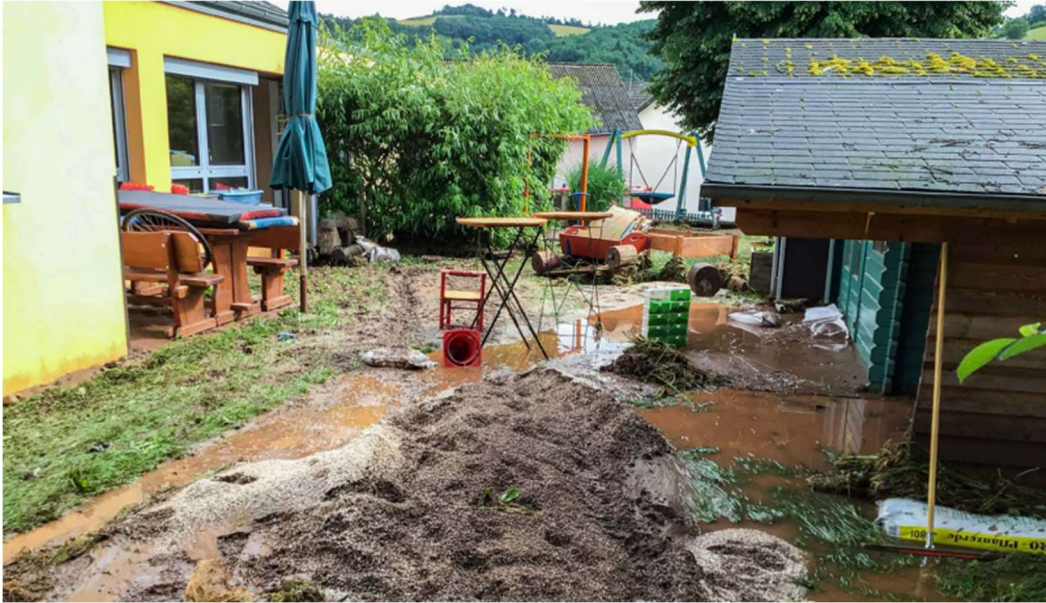
Aufnahme 5: Kitaschäden Hochwasser 2021 (eigene Aufnahme)
